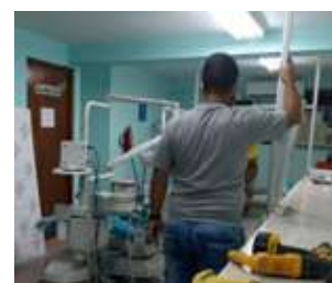
Instalación de mamparas acrílicas
