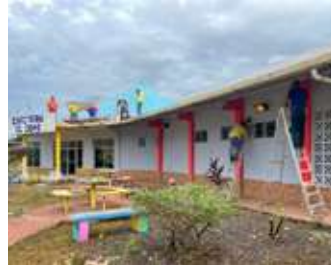
Reparaciones en el techado de la Cafetería del Domo
