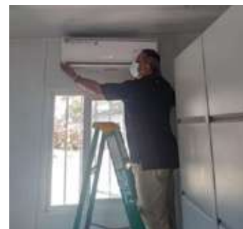
Instalación de siete aires acondicionados para oficinas administrativas
