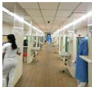
Instalación de mamparas acrílicas entre los cubículos de las clínicas
