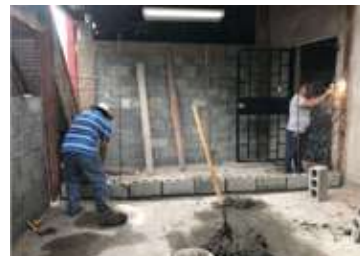
Trabajos de construcción en las paredes externas
