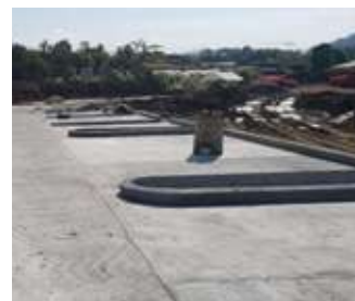
Construcción de estacionamiento del proyecto del nuevo Centro Regional Universitario de San Miguelito
