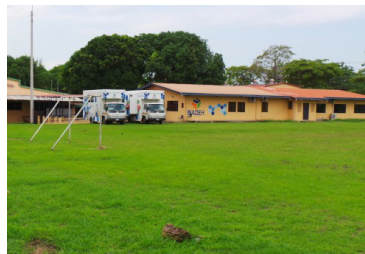
Edificación del INADEH en la finca 18444 de la UP en situación irregular. El edificio está emplazado en 3 hectáreas y se localiza en la vía Domingo Díaz.
