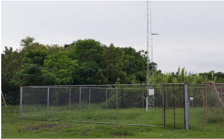
Construcción de cerca perimetral alrededor de la Estación Meteorológica del Centro Regional Universitario de Azuero
