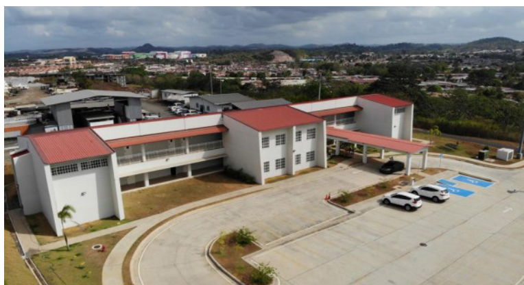
Edificio asignado a la Extensión Universitaria de Arraiján, ubicado en el Proyecto Ciudad Esperanza. Cuenta con dos niveles, dieciocho aulas de clases y tres oficinas administrativas.
