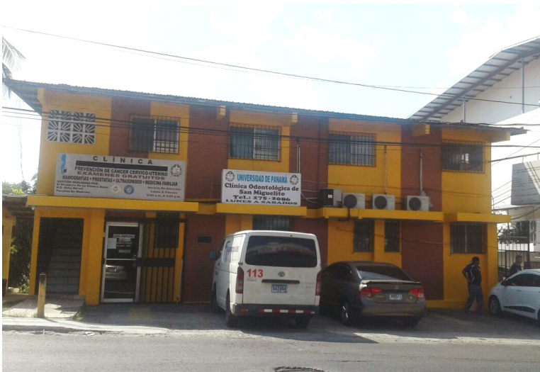
Instalaciones de la Clínica Familiar - San Miguelito
