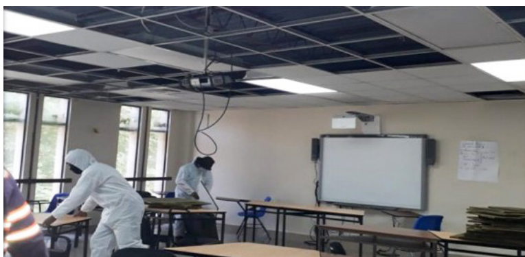
Remoción sistemática de la fibra de vidrio
