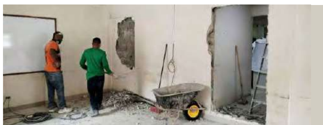
Trabajos de remodelación de oficinas
