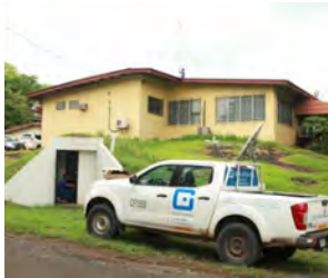
Inspección de viabilidad de Gold Data en la estación AZU
