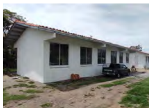
Construcción de aulas y laboratorios científicos
