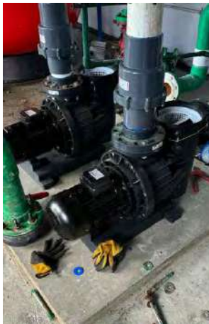
Instalación de bombas en la piscina Mgter. Alcides Bernal
