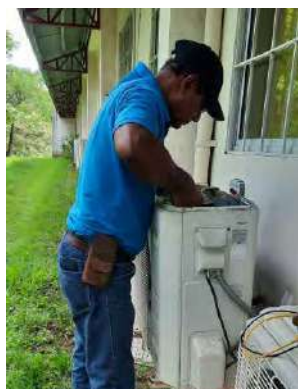
Mantenimiento a los aires acondicionados
