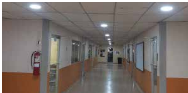
Cambio de luminarias del pabellón de aulas del edificio 550
