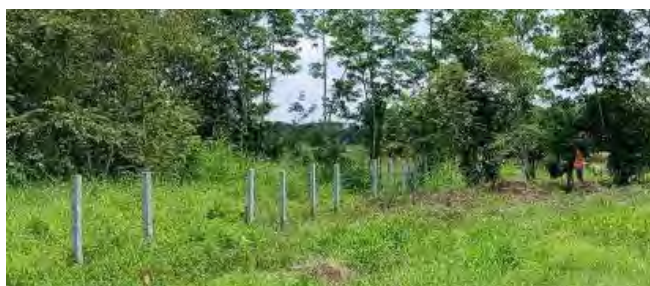
Inspección de los daños en la cerca perimetral de la Extensión
