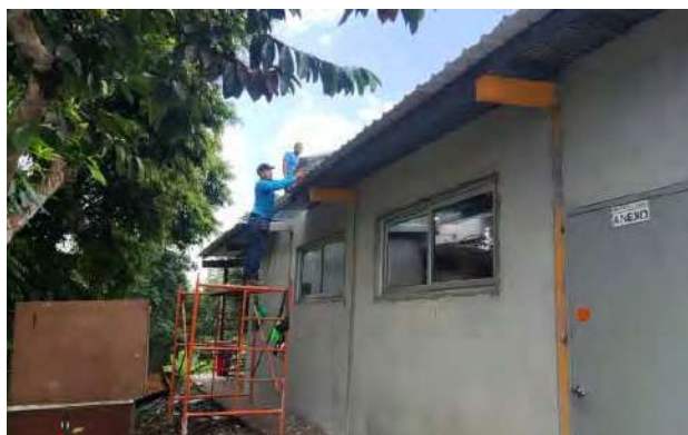
Trabajadores sobre andamios instalando techo en el anexo del salón de escultura
