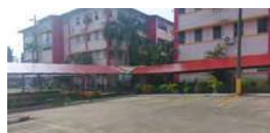
Cambio de techo en los pasillos exteriores de la Facultad
