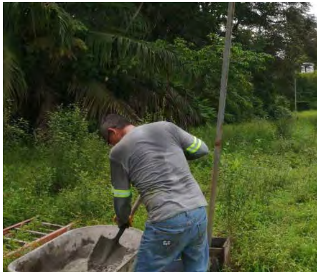
Mantenimiento correctivo a estación sísmica REME3 ubicada en el distrito de Remedios, Chiriquí
