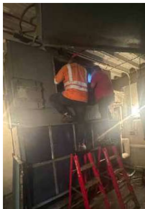
Cambio del blower de la manejadora del gimnasio B
