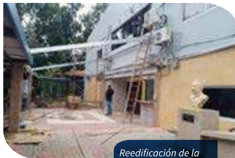
Reedificación de la entrada del auditorio
