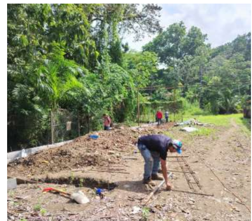
Trabajos de ampliación y acondicionamiento de estacionamientos en el Hospital
