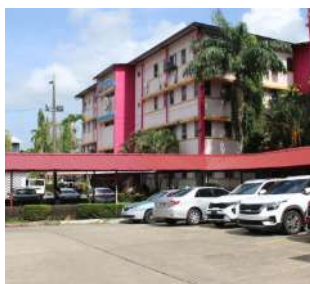
Instalación de techo entre las torres C-1 y C-2 de FAECO
