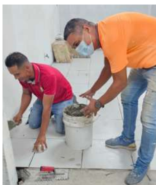
Mantenimiento correctivo de la facultad
