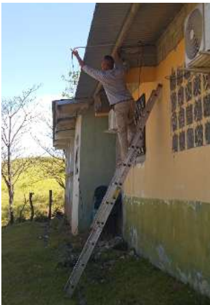
Mantenimiento de los equipos sísmicos en Infoplaza de El Vigui
