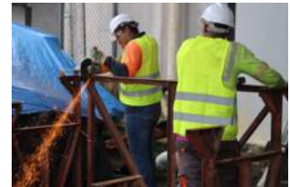
Trabajos de remodelación en el Gimnasio Universitario
