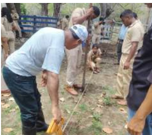
Preparación del terreno por parte de los estudiantes e instructores para la instalación de corrales móviles
