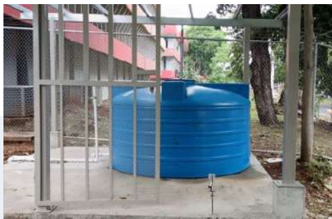
Adecuaciones físicas e instalación del sistema de almacenamiento de agua potable en el edificio del Departamento y Escuela de Inglés
