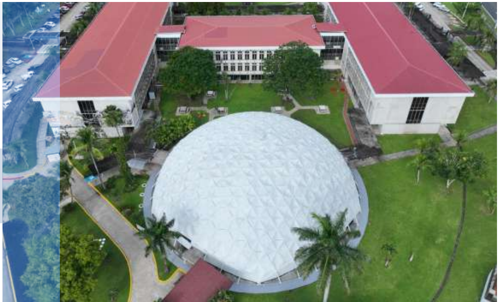
Impermeabilización y pintura de la cúpula del domo
