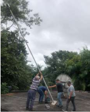
Mantenimiento del sistema de pararrayos
