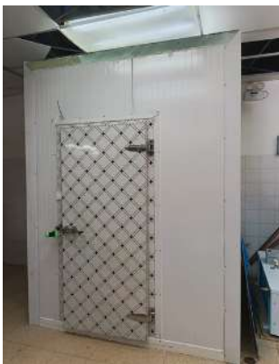
Adquisición e instalación de un cuarto frío para la cafetería universitaria
