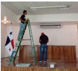
Personal de mantenimiento realizando trabajos en el sistema eléctrico
