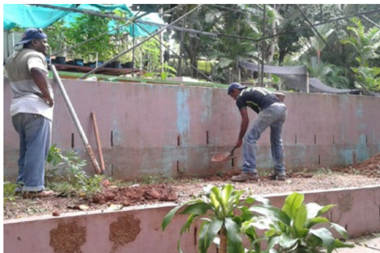
Adecuación del área donde se desarrollará el proyecto
