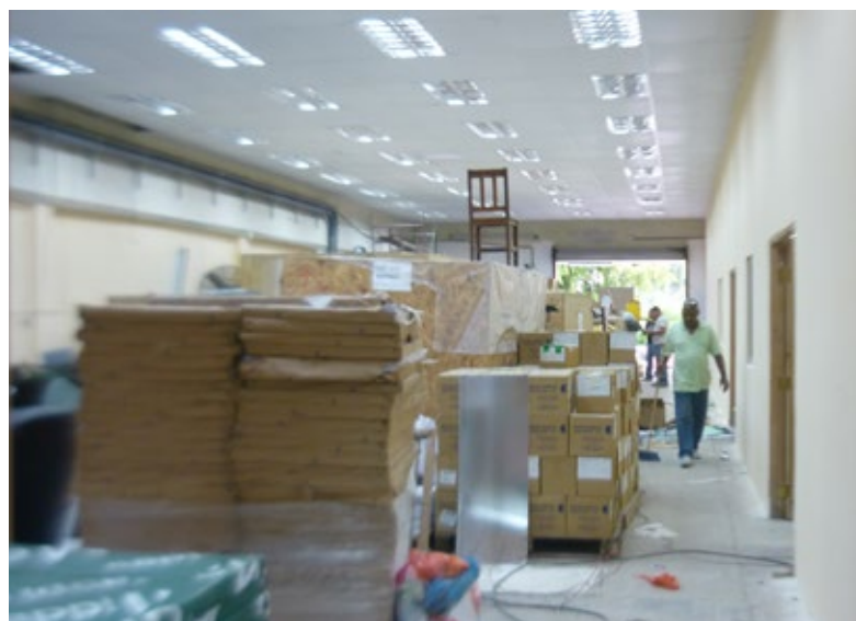
Remodelación de la Imprenta Universitaria
