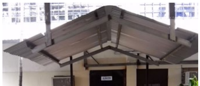
Entrada nueva al almacén
