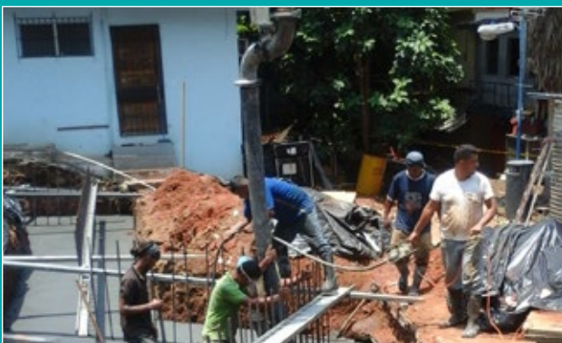
Construcción aulas de Clase de Enfermería y laboratorio de producción de la Facultad de Farmacia
